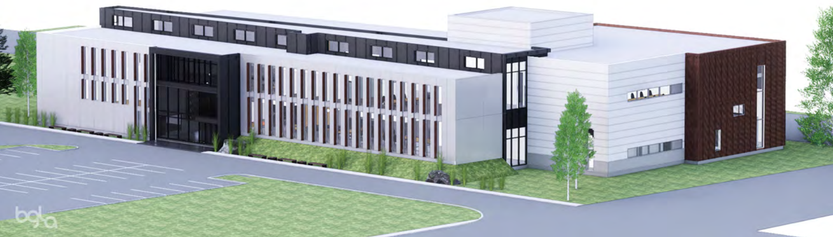
Vue extérieure du Pavillon de recherche et d'innovation Rio Tinto IOC
